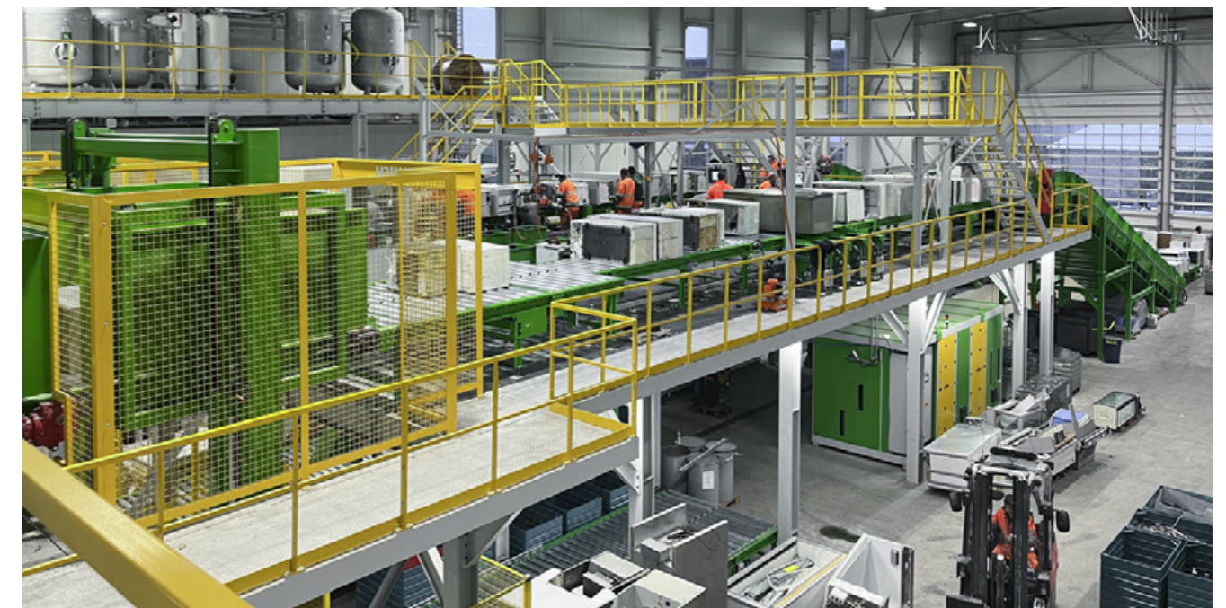
Erdwich-Kühlgeräte-Recyclinganlage der Immark AG. Mitte: Oberes Anlagendeck mit Absaugstationen, links: Geräteaufgabe in die zweite Verarbeitungsstufe, im Hintergrund die N2-Erzeugungsanlage.
