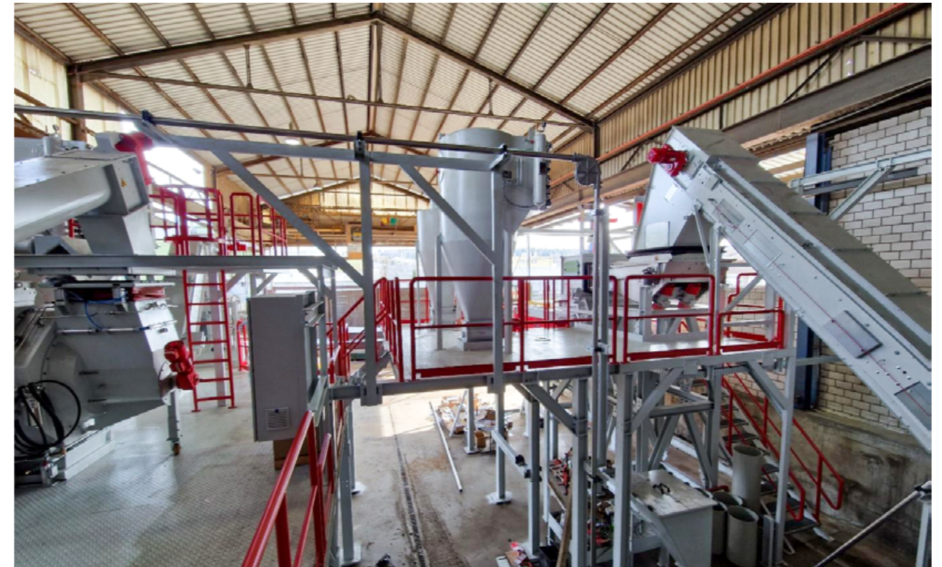
URT-Kühlgeräte-Recyclinganlage der E. Flückiger AG im Aufbau.
